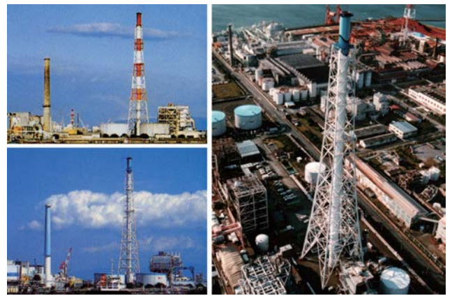
赤白からシンボルカラーへ塗り替えられた煙突。地元住民・事業者・行政が一体となって実現した、計画を象徴する取組。
