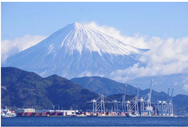
シンボルカラーによりデザインされたガントリークレーンが、富士山と調和した景観を形成している。
